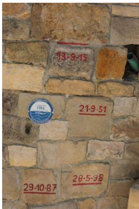
Figure 8. Exemple de repère de crue ayant été posé pour conserver la mémoire du risque d'inondation
